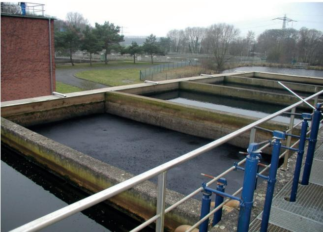
Abbildung 3: Offene GAK-Filter an der Kläranlage Obere Lutter (Quelle: AOL)
