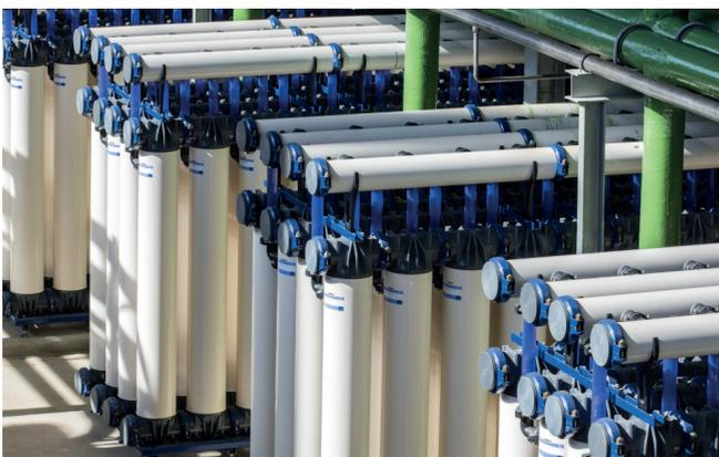
Abbildung 3: inge®-Module in einer Großanlage
