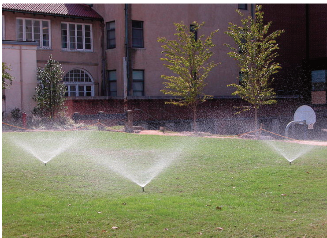
Abbildung 3: Rasensprenger im Einsatz an der North Carolina School of Science and Mathematics (Quelle: Ildar Sagdejev, Wikimedia Commons)
